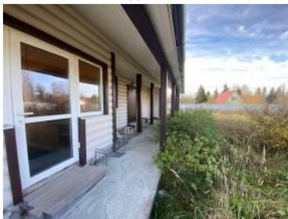
Жилой дом, 1 этаж, терраса ч.п. 8
