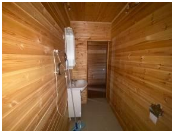
Жилой дом, 1 этаж, санузел ч.п. 6
