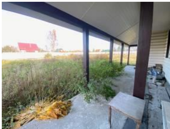
Жилой дом, 1 этаж, терраса ч.п. 8
