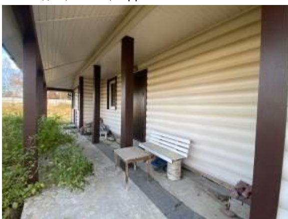
Жилой дом, 1 этаж, терраса ч.п. 8
