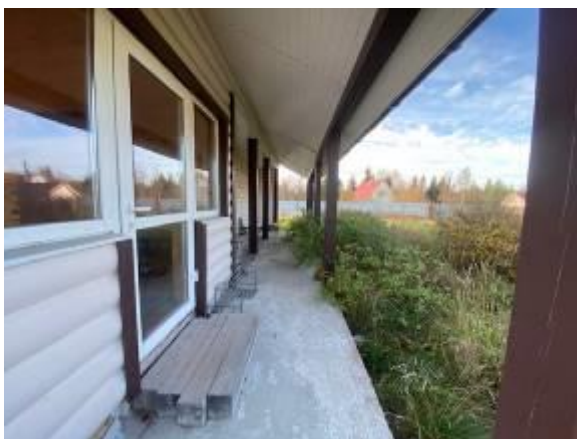
Жилой дом, 1 этаж, терраса ч.п. 8
