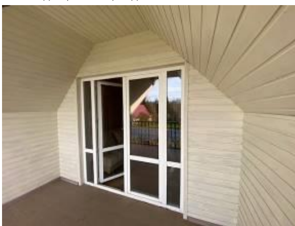
Жилой дом, 2 этаж, лоджия ч.п. 14
