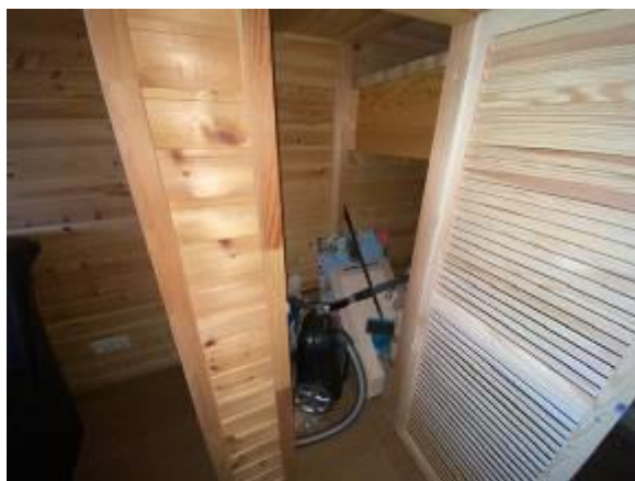
Жилой дом, 1 этаж, лестница
