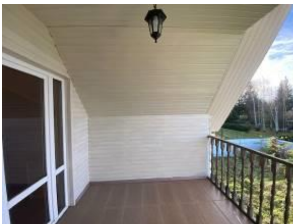
Жилой дом, 2 этаж, лоджия ч.п. 14
