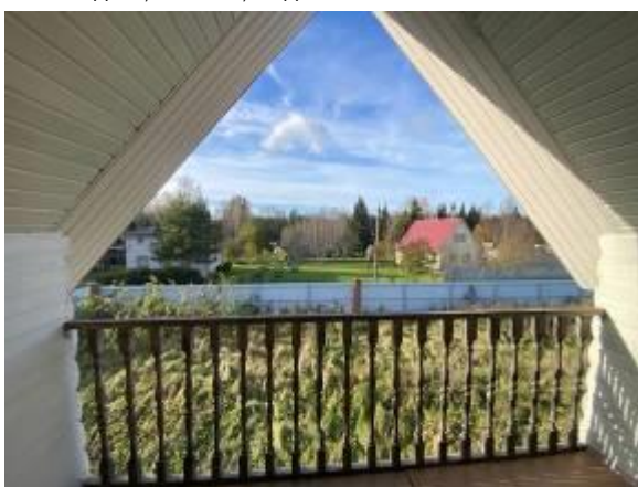
Жилой дом, 2 этаж, лоджия ч.п. 14
