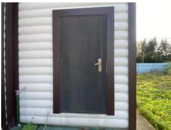
Жилой дом, 1 этаж, котельная ч.п. 3
