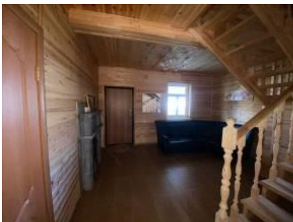
Жилой дом, 1 этаж, прихожая ч.п. 5
