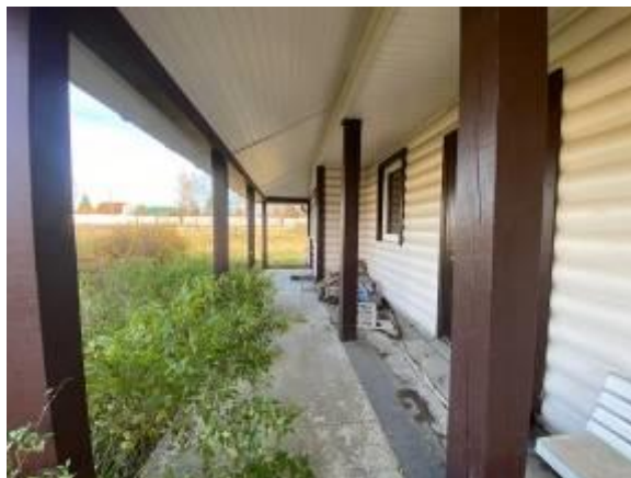
Жилой дом, 1 этаж, терраса ч.п. 8
