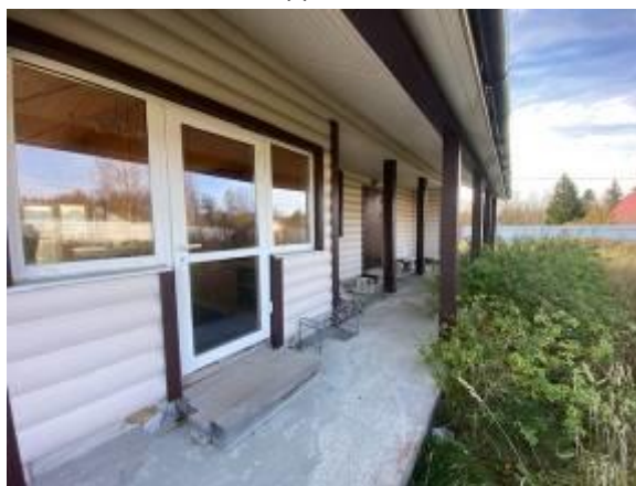
Жилой дом, 1 этаж, терраса ч.п. 8
