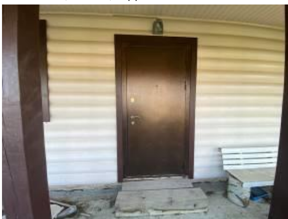
Жилой дом, 1 этаж, терраса ч.п. 8
