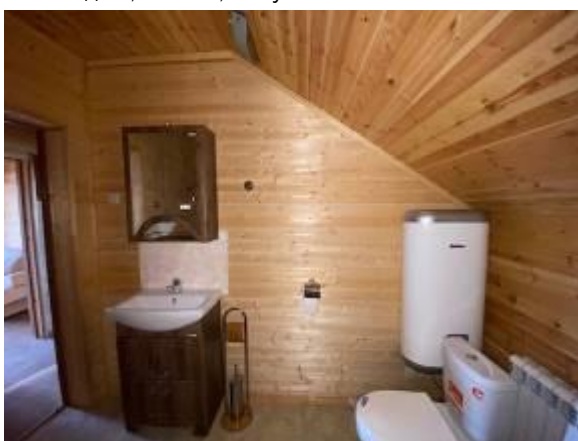
Жилой дом, 2 этаж, санузел ч.п. 13
