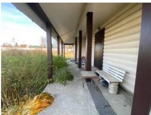
Жилой дом, 1 этаж, терраса ч.п. 8
