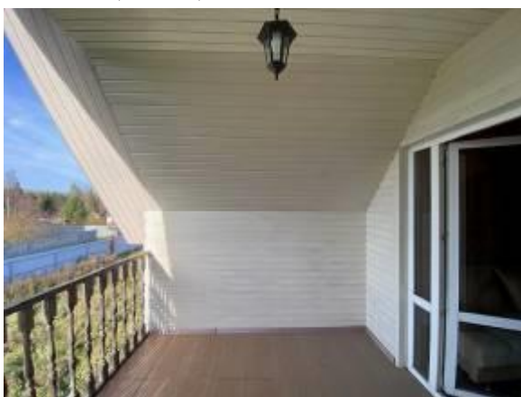
Жилой дом, 2 этаж, лоджия ч.п. 14
