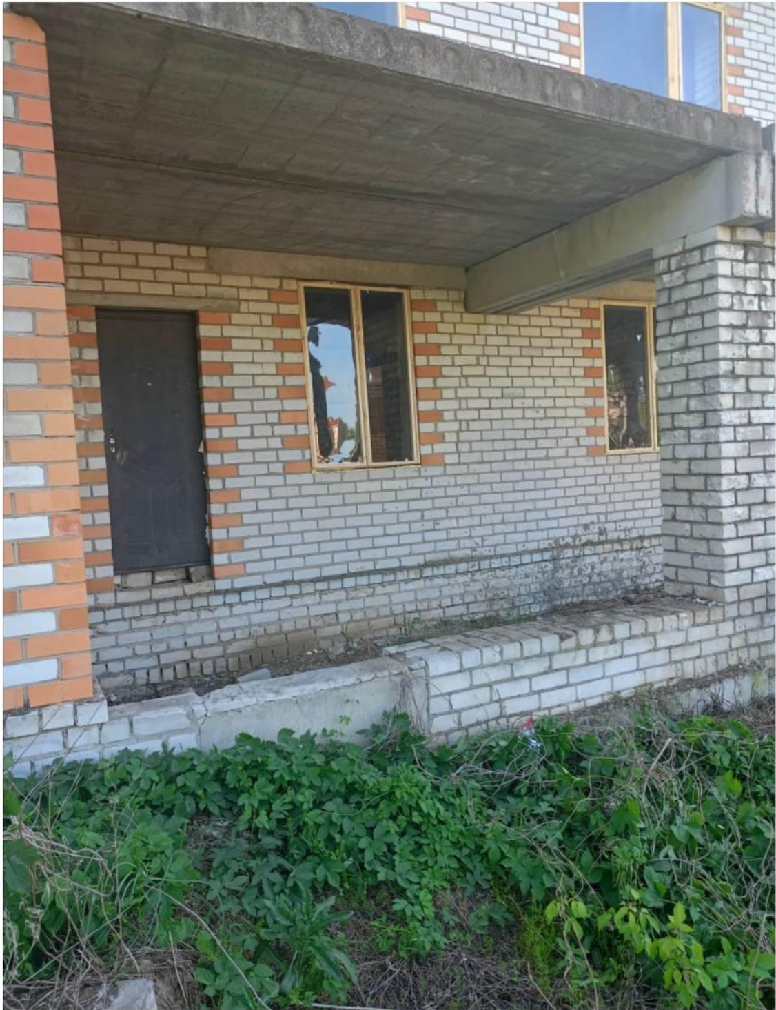
Входная дверь и первый этаж снажаружи
